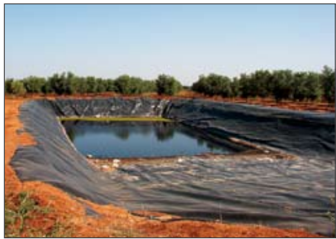
FOTO: Balsa de evaporación de efluentes / FUENTE: ASOCAN
